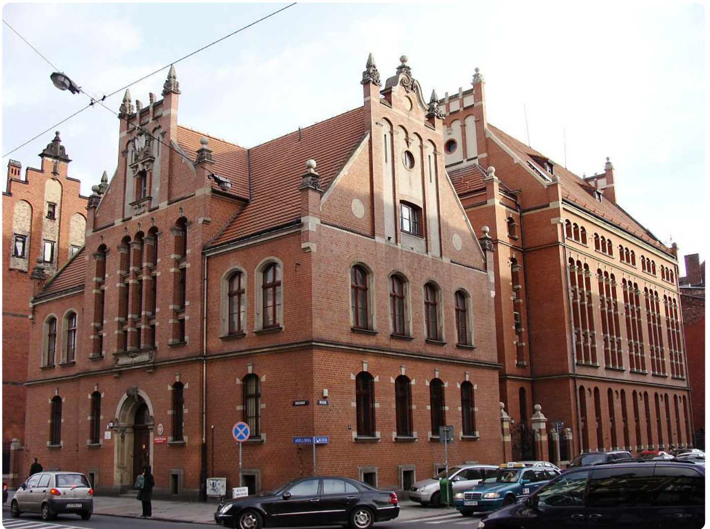
Budynek Archiwum Państwowego przy ul. św. Wojciecha w Szczecinie
