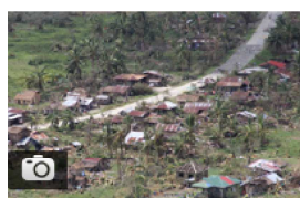
Zniszczenia po przejściu...
