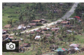
Zniszczenia po przejściu...
